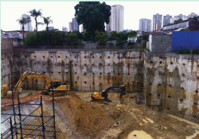
Escavação que deu origem aos 4 andares de estacionamento no subsolo.
